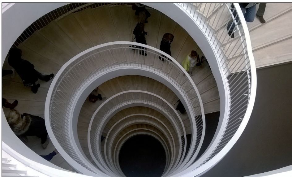
Fot. 10. Biblioteka Uniwersytetu Helsińskiego, „ślimak” klatki schodowej.
