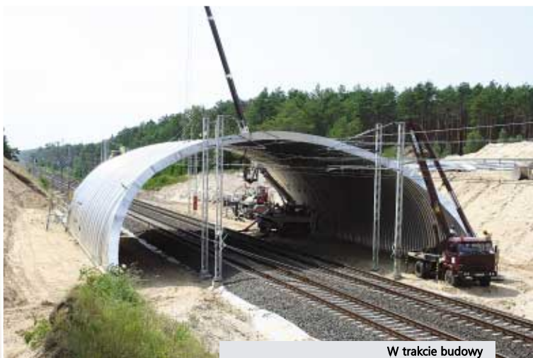
W trakcie budowy fot. IR Poznań
