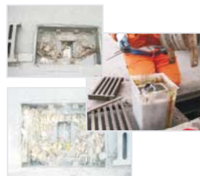
Rys. 5. Wymiana worków Aikaterisil™ po kwartale użytkowania
