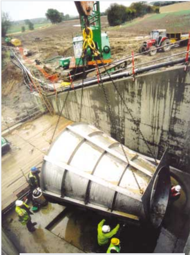
Instalowanie regulatora przepływu „Hydro-Brake®” w tamie Weedon
