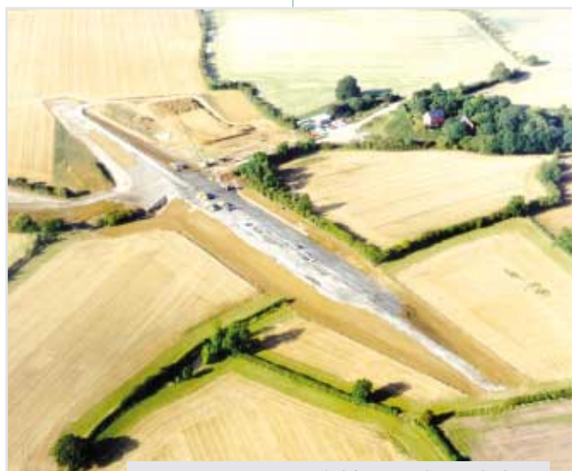
Widok tamy podczas jej budowy
