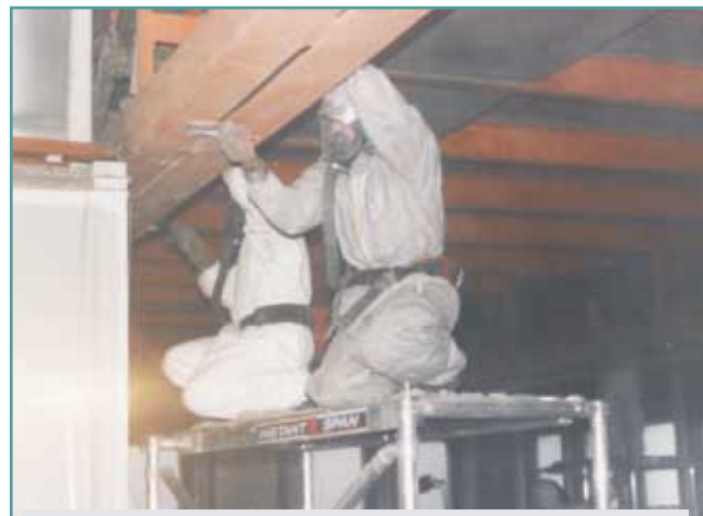
Pracownicy przy skuwaniu otuliny cementowo-azbestowej
