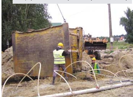
Prace przy budowie kanalizacji deszczowej na osiedlu Winiary
