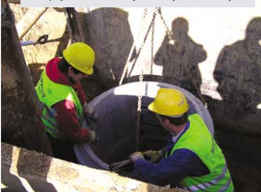
Prace przy budowie kanalizacji sanitarnej na osiedlu Majków
