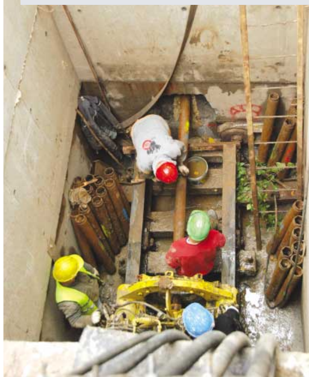
Fot. Przewiert metodą mikrotunelingu – Al. Unii Lubelskiej
