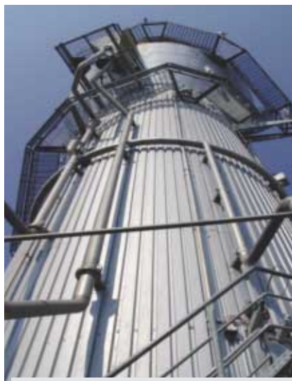
Fot. 7. Reaktor beztlenowy, przemysł spożywczy
