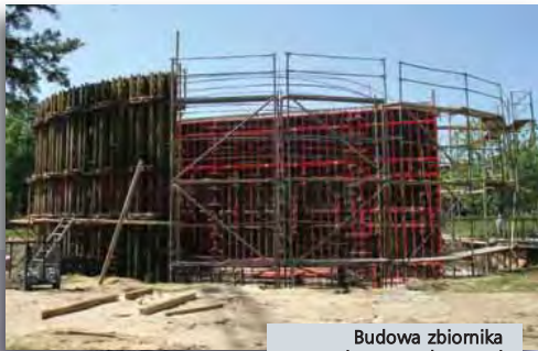
Budowa zbiornika retencyjnego wody czystej
