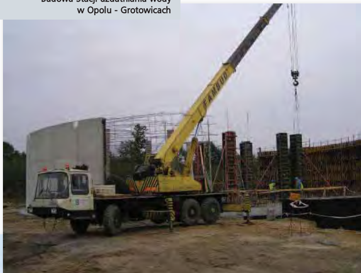
Budowa Stacji uzdatniania wody w Opolu - Grotowicach
