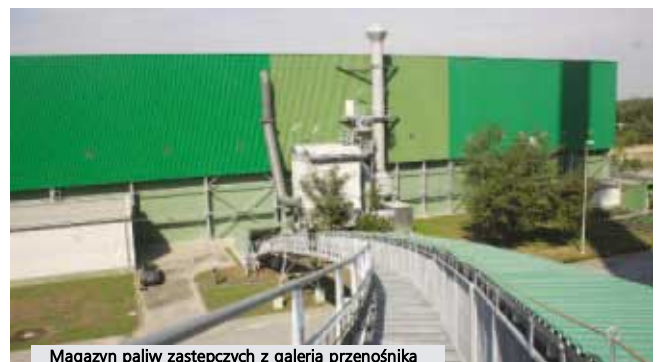
Magazyn paliw zastępczych z galerią przenośnika taśmowego-rurowego do transportu paliw
