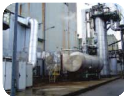
Instalacja spalatora ścieków
