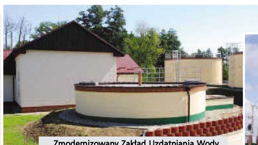
Zmodernizowany Zakład Uzdatniania Wody (ZUW-3), Podłęże
