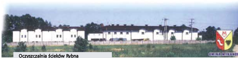
Oczyszczalnia ścieków Rybna
