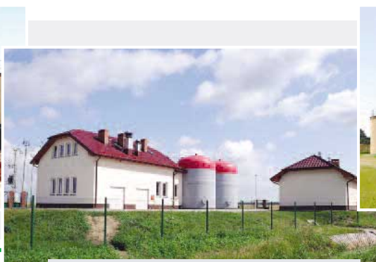
Nowopowstała oczyszczalnia ścieków: obiekt o przepustowości 295 m 3 /dobę, Wola Zabierzowska
