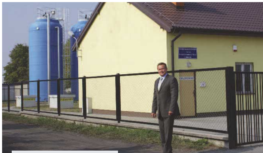
Stacja Uzdatniania Wody w Janowie
