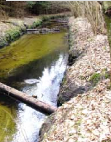
Fot. na górze: próg wodny z bystrotokiem Fot. na dole: ostrogi z bali drewnianych mających na celu wywołanie meandrowania nurtu rzeki. Fot. A. Ryś, źródło:ww. dokument
