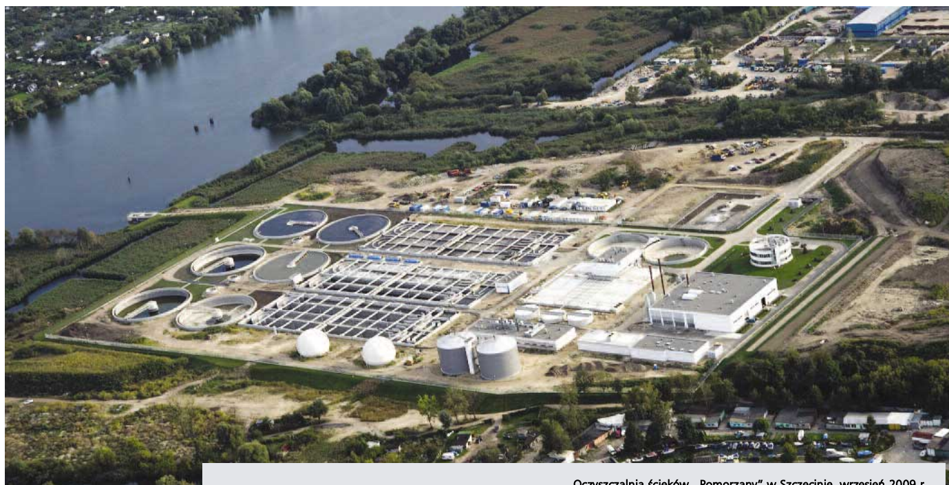
Oczyszczalnia ścieków „Pomorzany” w Szczecinie, wrzesień 2009 r.
