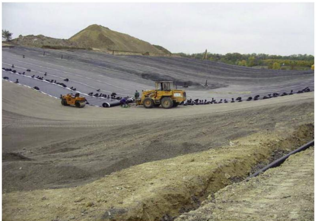
Pierwsze prace – październik 2007 rok. Fot. Deponieabschluss Budenheim mit Folgenutzung Golfplatz, Januar 2008
