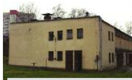
Budynek Przepompowni Głównej – stan obecny
