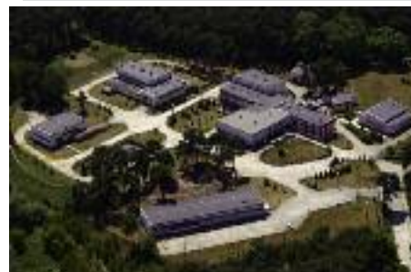
Ujęcie i Stacja Uzdatniania Wody „Krzywe Błota” z lotu ptaka
