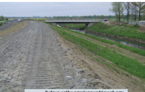
Budowa wałów przeciwpowodziowych przy częściowym wykorzystaniu odpadów górniczych
