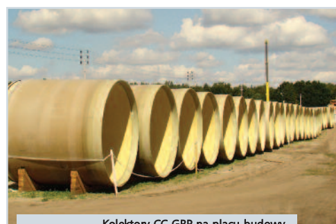
Kolektory CC-GRP na placu budowy
