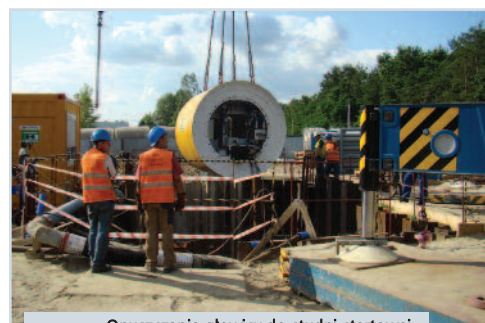
Opuszczanie głowicy do studni startowej
